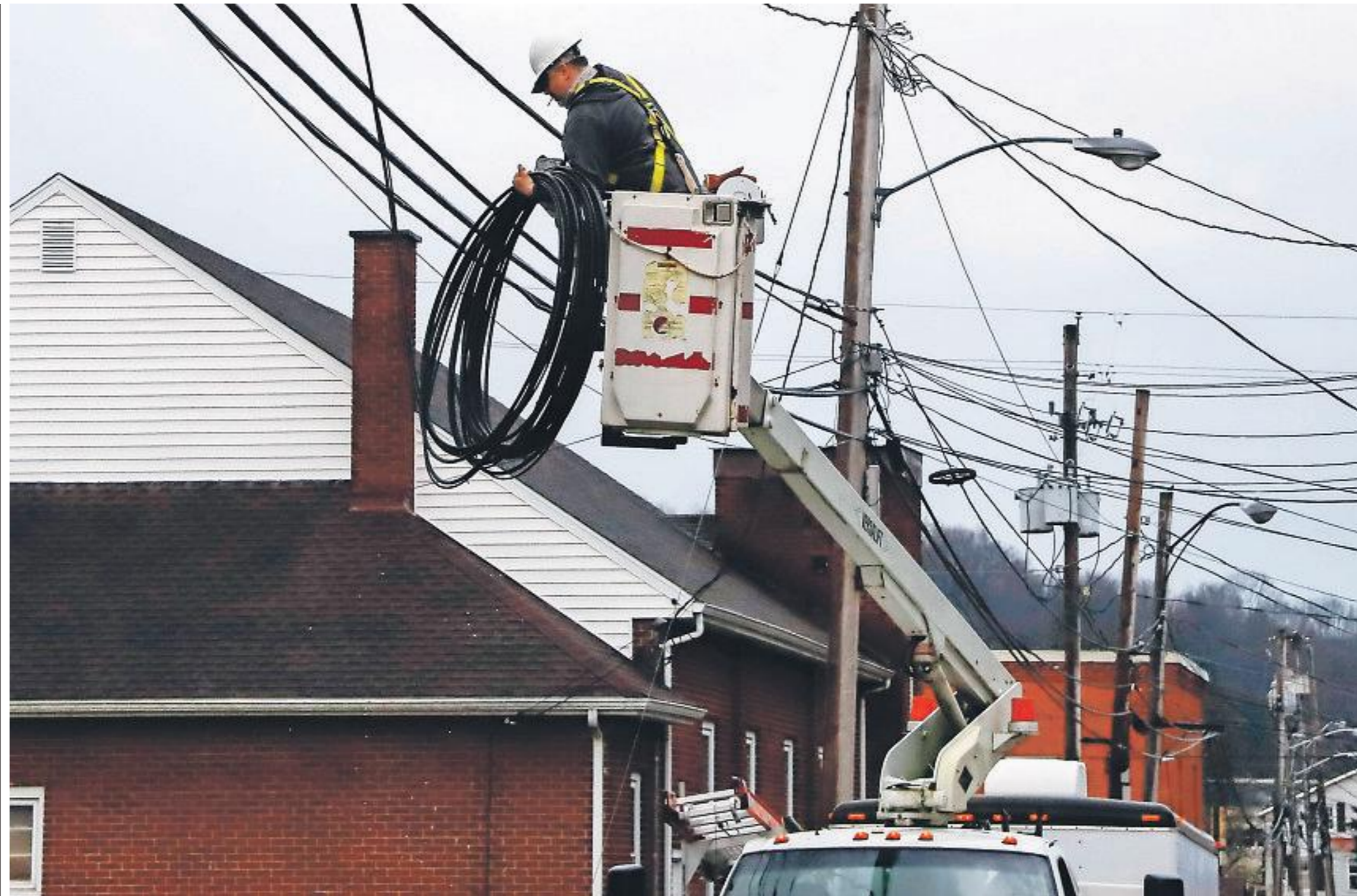
Aanleg van glasvezelkabels in Ohio. In de VS is toegang tot goed internet nog vaak beperkt en duur. De staat Ohio heeft wel een programma om het internetbereik te vergroten.
