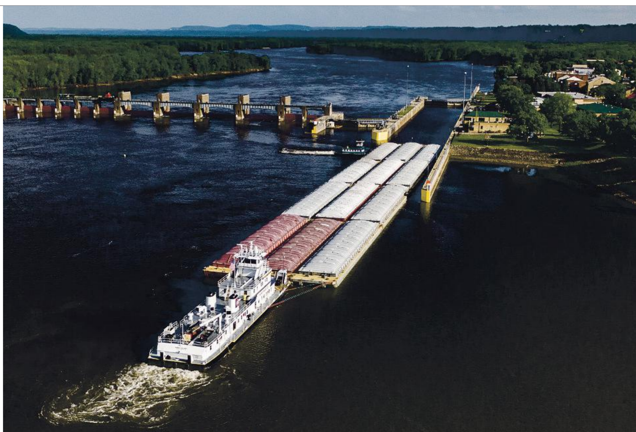
Sluisdam nummer 10 in de Mississippi nabij Guttenberg in de staat Iowa. De sluis, ruim 33 meter breed en 180 meter lang, dateert uit 1937.
